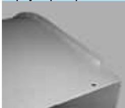
Для предотвращения коррозии в стыках при работе с влажными или агрессивными средами возможна сварка корпуса сплошным швом. При "Сплошном проваре" достигается относительная герметичность корпуса.
