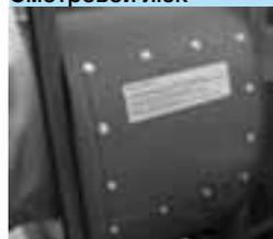
Для осмотров и чистки на корпусе вентилятора имеется смотровой люк, надежно закрытый крышкой.
